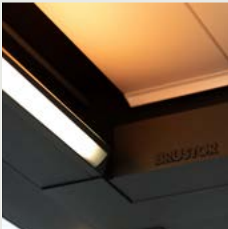
ÉCLAIRAGE LED SUR LA GOUTTIÈRE
